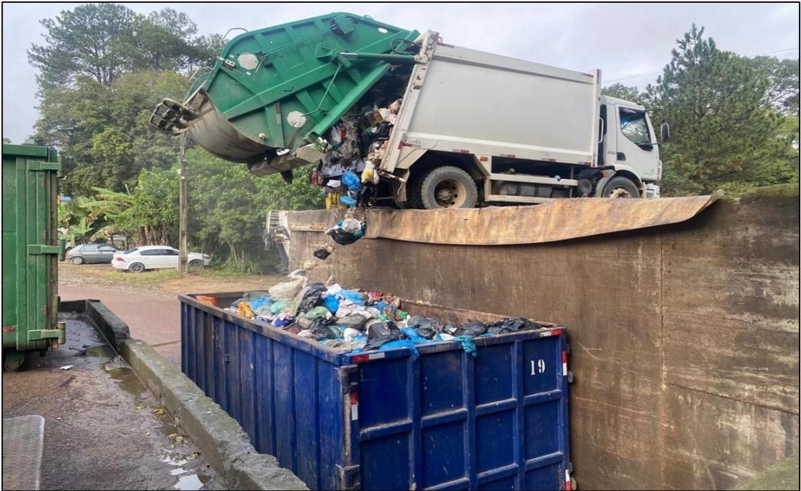
**Figura 15 – Plataforma de transferência da Estação de Transbordo**
